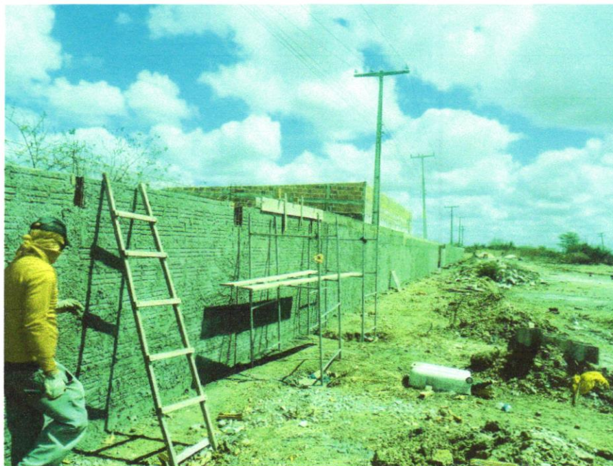
Foto 03 – MASSA ÚNICA, PARA RECEBIMENTO DE PINTURA, EM ARGAMASSA TRAÇO 1:2:8, PREPARO MANUAL, APLICADA MANUALMENTE EM FACES INTERNAS DE PAREDES, ESPESSURA DE 10MM, COM EXECUÇÃO DE TALISCAS
